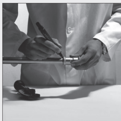
Rys. 22 Umieszczenie rury w złączce i oznaczenie głębokości montażowej
